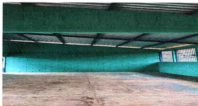
Foto 3: TRABAJO DE FINALIZACION DE MANTENIMIENTO DE MUROS INTERIOR Y EXTERIOR
