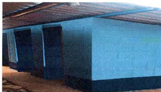
Foto 4: TRABAJO DE FINALIZACION DE BAÑOS
