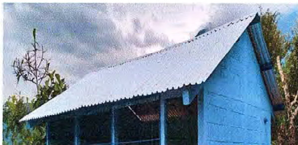
Foto1: FINALIZACION DE SUSTITUCION DE LAMINAS A LAMINAS TROQUELADAS
