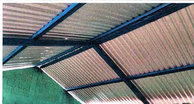
Foto 2: FINALIZACION DE MANTENIMIENTO DE ESTRUCTURA
